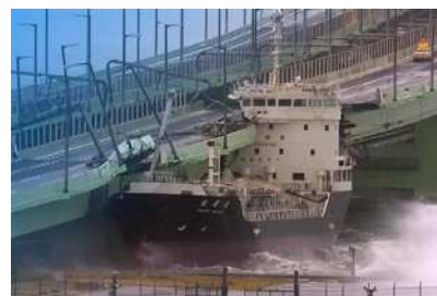
連絡橋に衝突したタンカー
