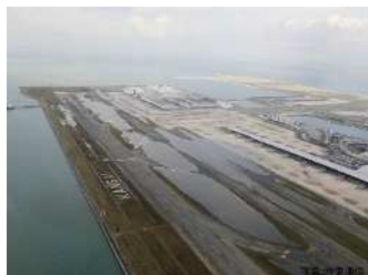
高潮の被害を受けた関西国際空港
