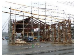
↑合掌半分撤去完了
