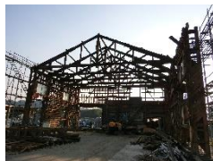
↑解体半分完了！
