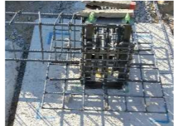
↑鉄筋配筋助教
