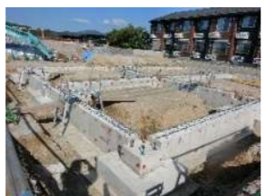
↑地中梁コンクリート
