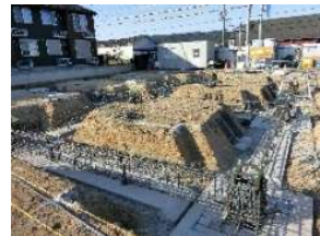
↑地中梁鉄筋配筋完成
