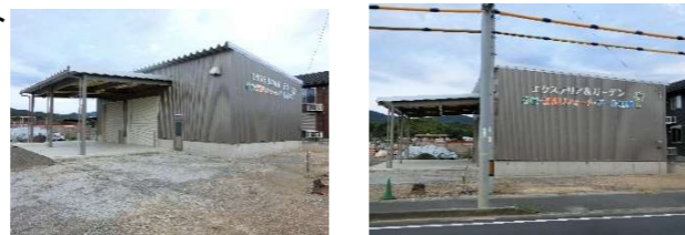
完成した倉庫→
