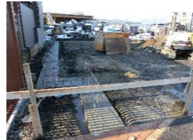
↑展示場の擁壁工事
