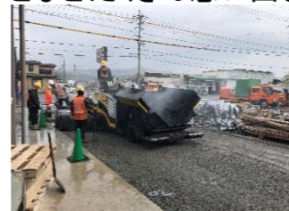
↑倉庫前の舗装
