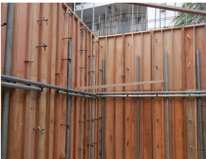
持続可能性に配慮した調達コードにある木材と同等の素材を使った型枠コンクリートパネル。
