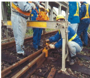
軌道整備イメージ (レール交換作業)
